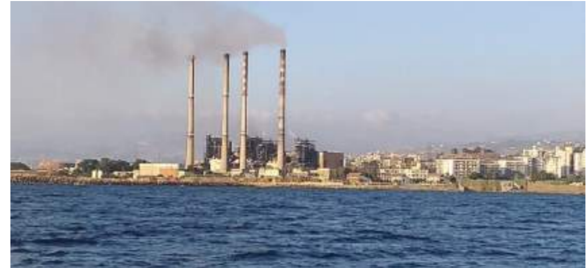
شكل 17: مصفاة بانياس لتكرير النفط
