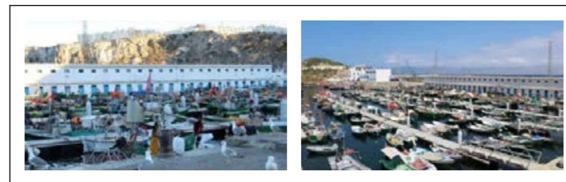
Figure 55 Photos des enceintes du port d'Al Hoceima.
