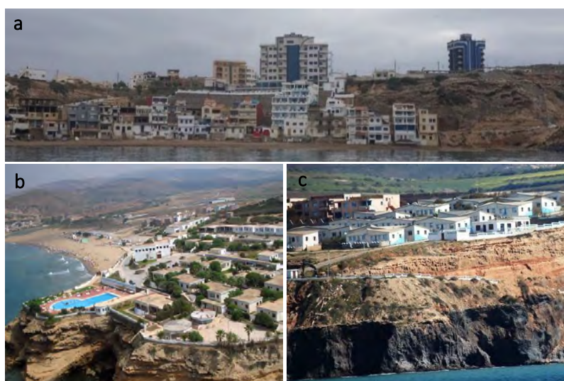
Figure 93. Infrastructures touristiques de la localité de Rachgoun. a) Hôtels et résidences de la plage de Madrid (Beni Saf), b) Complexe touristique le Syphax, c) Complexe touristique El Nabil (Photos. « a » © M. Benabdi,
