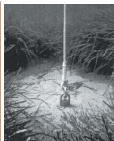
Fig. 81. L’anneau de fixation d’un mouillage de type Harmony, avec départ du câble d’amarrage, dans un herbier à Posidonia oceanica . D’après Smat Neptune Environnement (2000).
