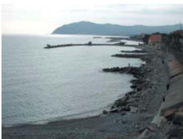
Fig. 63. Cervo (Province d'Imperia : Ouvrage de défense contre l'érosion de la côte et de la ligne ferroviaire (Archives Settore Ecosistema Costiero - Regione Liguria).
