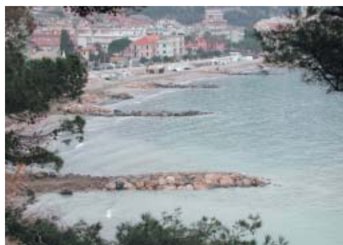
Fig. 66. Laigueglia (Province de Savona) : Ouvrage de défense de la côte contre l'érosion (Archives Settore Ecosistema Costiero - Regione Liguria).
