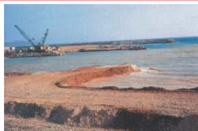
Fig. 59. Aménagement des plages artificielles du Mourillon (Toulon, Var, France). Les sédiments fins sont entraînés par l'hydrodynamisme. D'après Astier et al. (1980).
