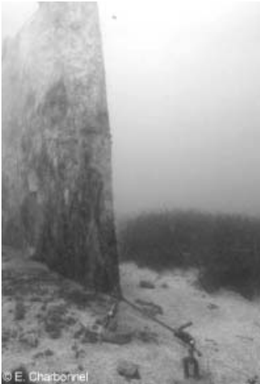
Fig. 73. Un écran en géotextile (à gauche), protégeant un herbier à Posidonia oceanica (à droite), lors de travaux sous-marins sur le site du Canier (Var, France). Photo E. Charbonnel.
