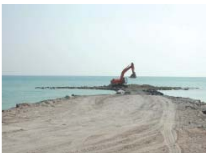
Fig. 65. Borghetto Santo Spirito (Province de Savona) : Réalisation d'un ouvrage de défense côtière (Archives Settore Ecosistema Costiero - Regione Liguria).
