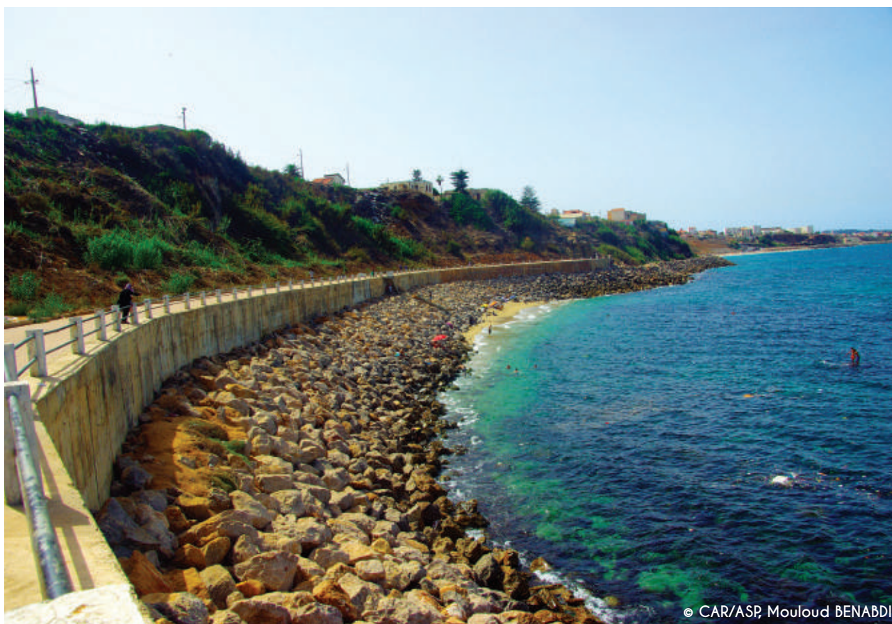
Figure 5: Ouvrage de protection à terre pour lutter contre les effets de l'érosion côtière à Ain Taya
