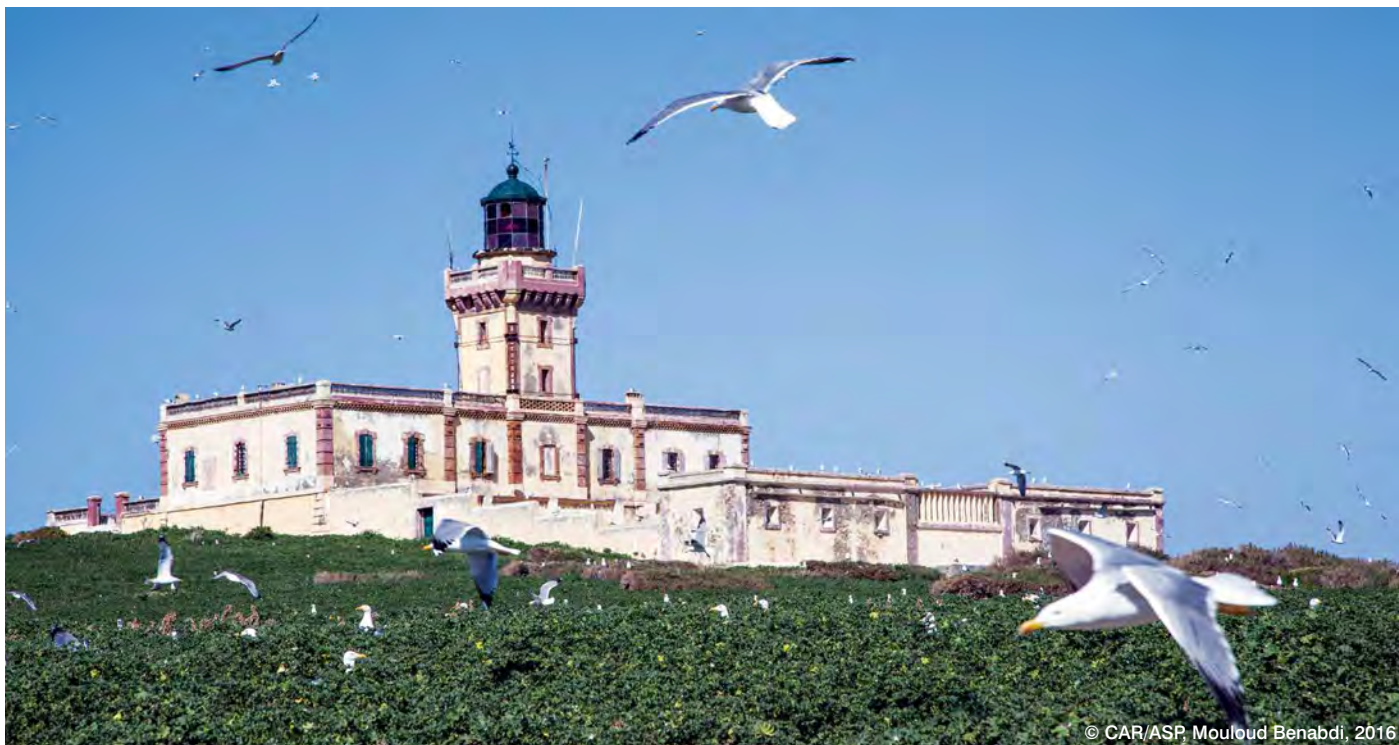
Figure 1-1. Façade Ouest du phare de Rachgoun
