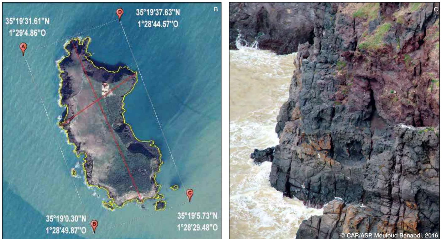
Figure 1-2. (a) Situation de l'île de Rachgoun (Source: fond de carte SAS Planet, 2016 modifié) ; (b) Coordonnées et périmètre de l'île de Rachgoun (Image CNES/Astrium in Google Earth Pro Modifiée) ; (c) Traces volcaniques sur les flans de l'île de Rachgoun
